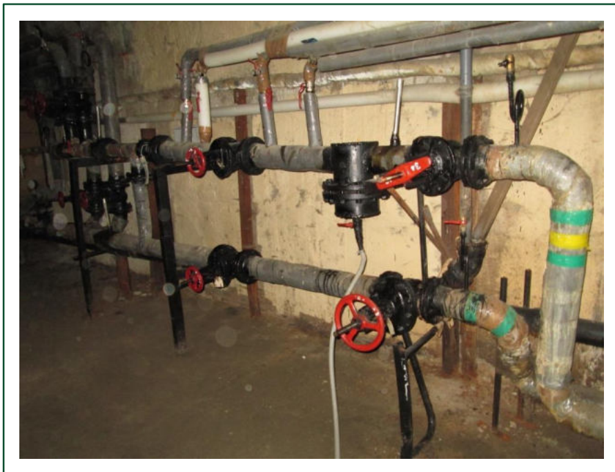
ПОДВАЛ ДО УСТАНОВКИ АУУ
