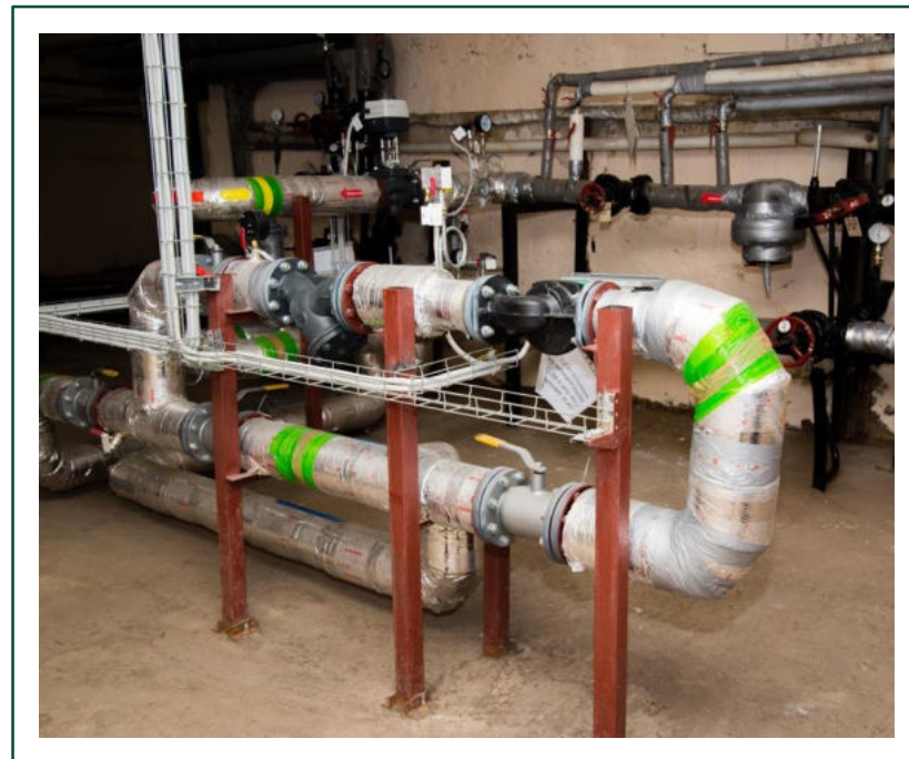
СМОНТИРОВАННЫЙ АУУ В ПОДВАЛЕ ДОМА
